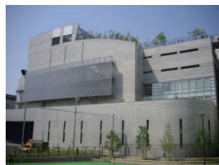
首都高速中央環状新宿線大橋換気所
