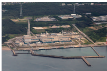
柏崎刈羽原子力発電所
