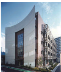
造幣局研究棟
