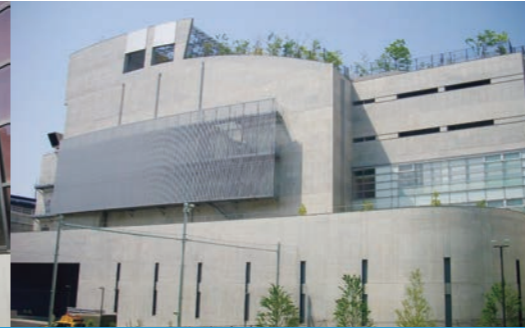
2013年 中央環状新宿線大橋換気所 (設計・工事監理)
