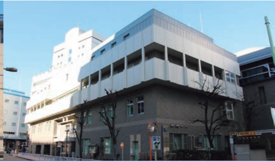
2016年 江東区深川スポーツセンター (改修設計・工事監理)
